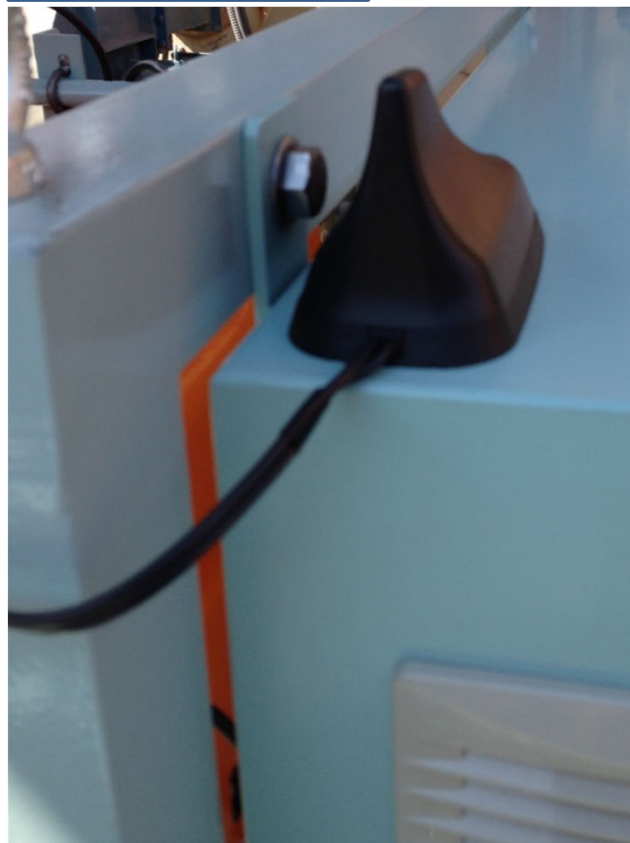
設置写真2(アンテナ)
